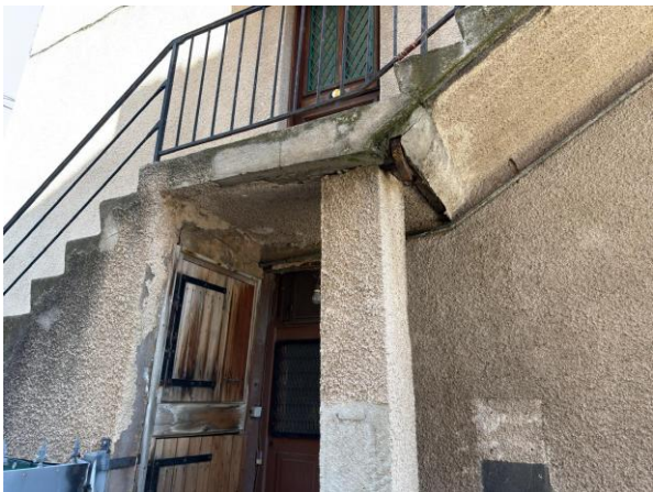
Profils visibles au droit de l'accès extérieur.
