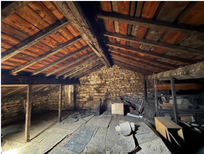
Pannes, chevrons et volige visibles depuis les combles.
