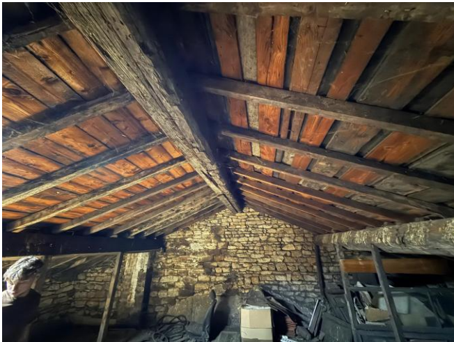
Vue d'ensemble de la charpente accessible.
