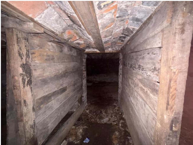
Solivage et appuis visibles depuis la cave.
