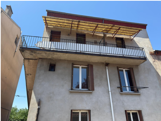
Vue générale de la coursive.
