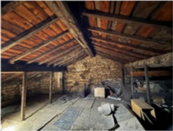
Pannes, chevrons et voilge visibles depuis les combles.
