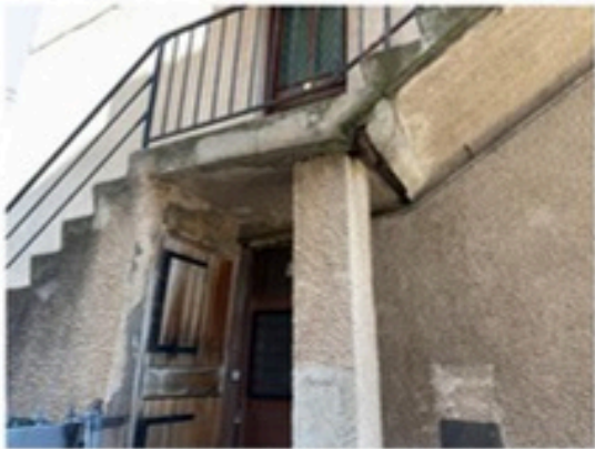
Profils visibles au droit de l'accès extérieur.
