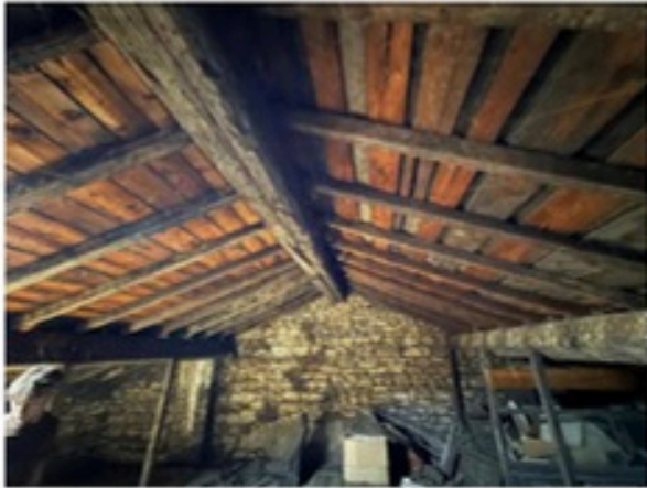
Vue d'ensemble de la charpente accessible.
