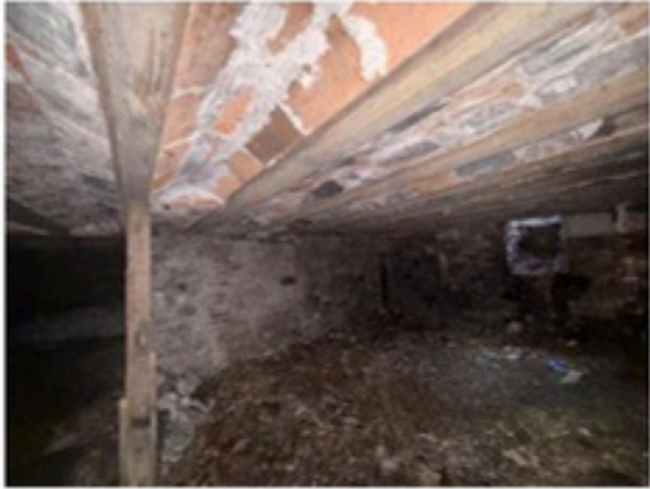
Vue générale de la sous-face du plancher sur cave.
