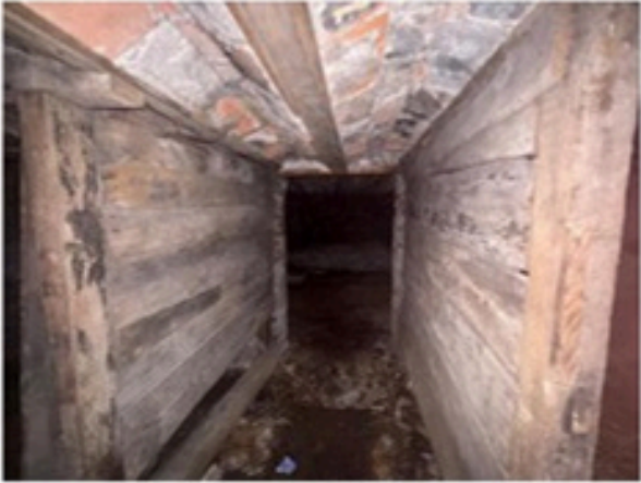
Solivage et appuis visibles depuis la cave.
