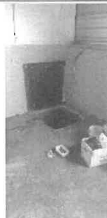
Photographie 10 : Trappe d'accès au local cuves depuis l'atelier
