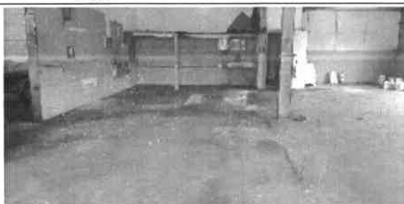
Photographie 6 : Partie atelier mécanique
