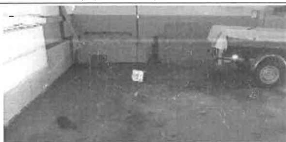
Photographie 5 : Zone peinture – côté sud-est
