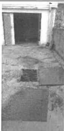
Photographie 13 : Grille d'eaux pluviales devant le local cuves
