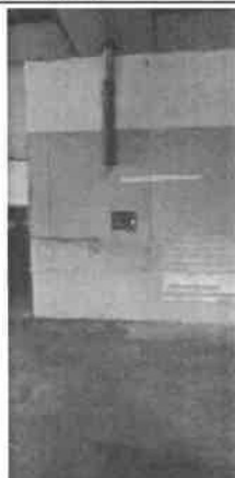
Photographie 7 : Emplacement de l'ancienne chaudière
