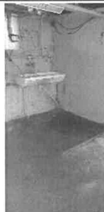
Photographie 8 : Coin lavabo de l'atelier mécanique
