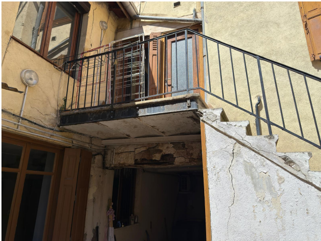
Vue générale de l'escalier et du palier.
