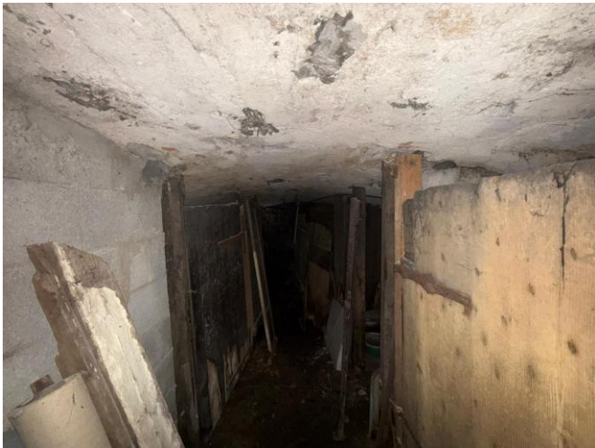
Circulations et volumes de cave à dégager.
