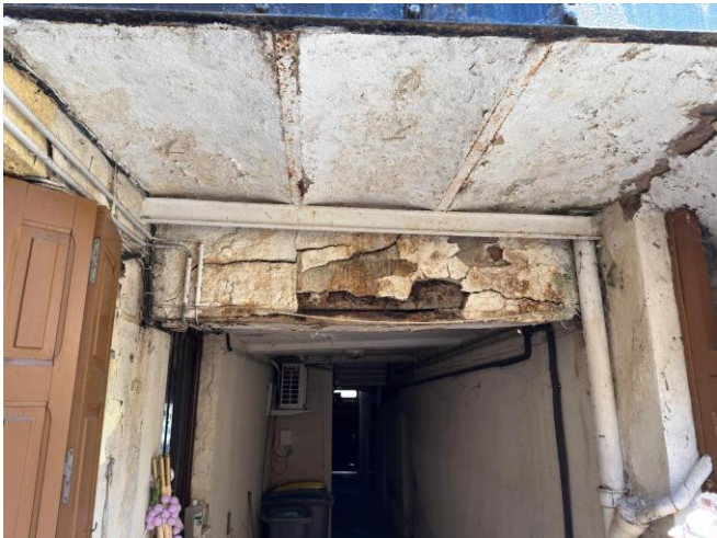
Sous-face du palier et éléments structurels associés.
